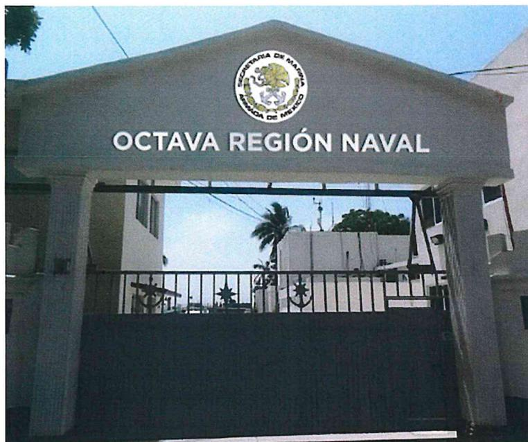
3. Letras en 3D elaboradas completamente en aluminio plata cepillado, canto de 0.04 cm interiores en trancara de PVC de 6 mm Led blancos de alto brillante y fuente de poder, considerando el ranurado en muro para ocultar el cableado.
